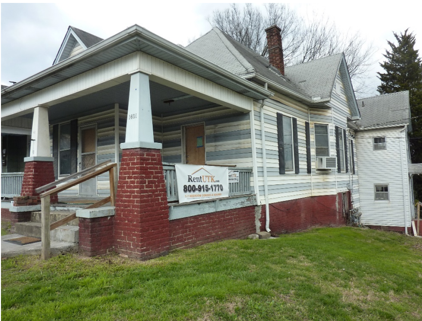
Front view facing south to Forest Av
