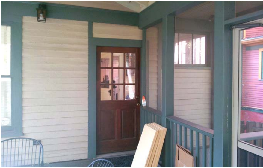
Existing back door
